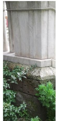
Fig. 6, Fig. 7. Recinto semicircolare retrostante il prospetto della fontana: la base è realizzata in elementi di matrice calcarea, analogamente a quanto indicato in sede progettuale da C. Biondetti. Tale morfologia del paramento murario è discernibile fin dalle foto storiche di fine XIX secolo. Rilievo fotografico del 27/03/2014.
