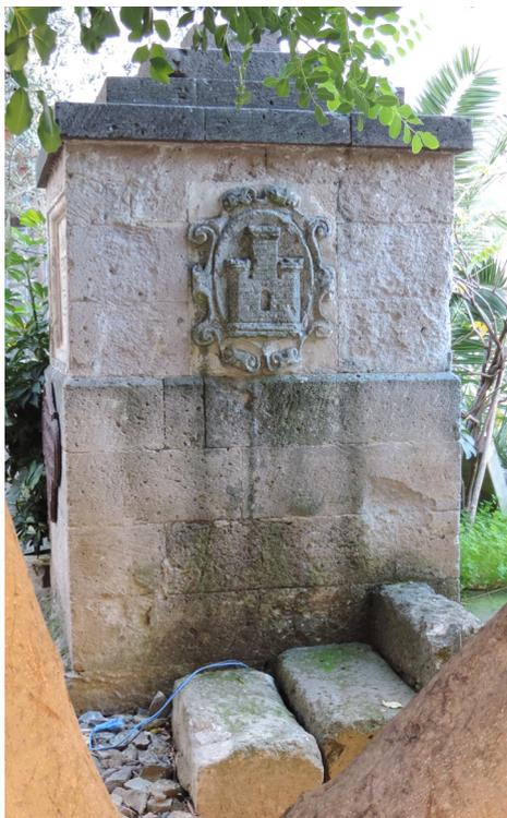
Fig. 1. Parallelepipedo di pianta quadrata, in conci lapidei di matrice calcarea. Potrebbe esser stato sistemato durante i lavori del 1881-2. Rilievo fotografico del 27/03/2014.
